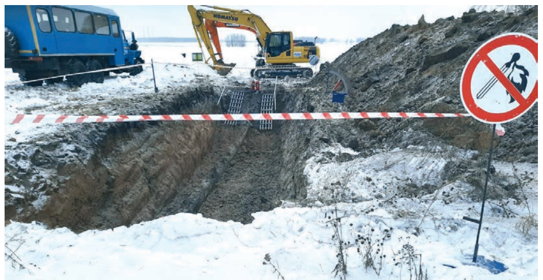
Огневые работы на газопроводе-отводе к ГРС «Топки»
