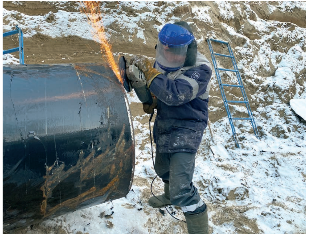
Устранение дефектов на МГ Омск – Новосибирск
